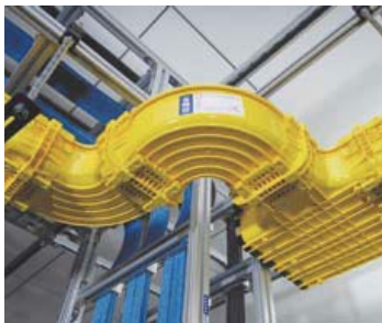
光纤槽道水平弯头
