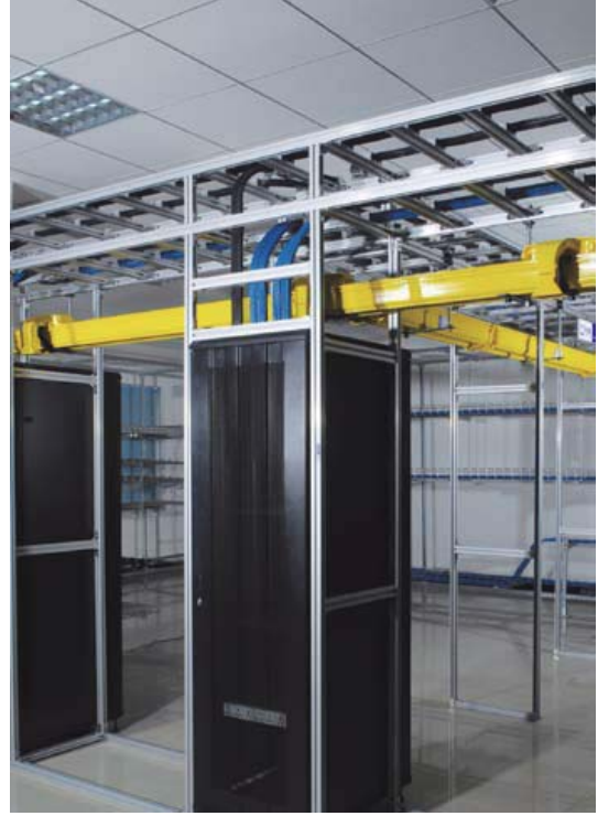
地面支撑安装方式
