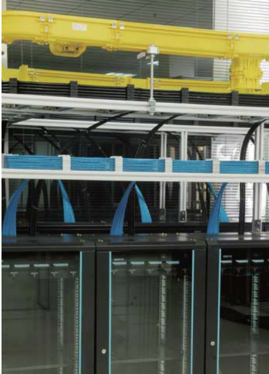
机柜顶部安装方式
