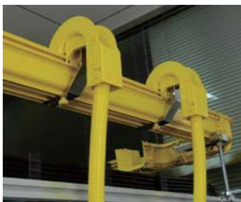
光纖槽道下引
