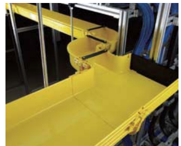
光纖槽道水平彎頭及出口
